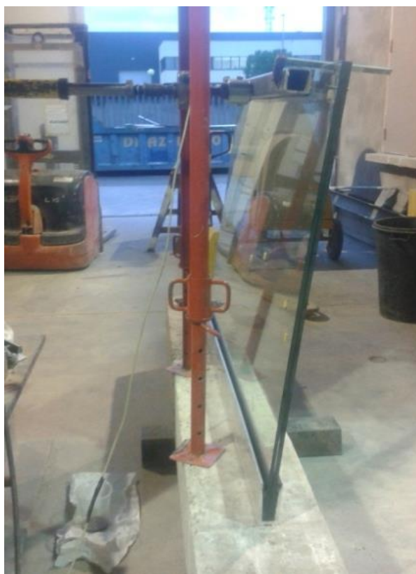
Detalle de la puesta en carga.
